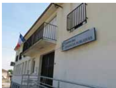
Contrairement à ce qu'on peut lire sur sa façade, la trésorerie de Dieuze n'est plus un centre des finances publiques, comme c'est le cas à Château-Salins. Photo RL/Philippe DERLER Photo : Le Républicain Lorrain
